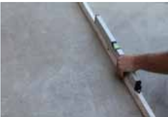
Yüzeyin düzgünlüğünün kontrol edilmesi
