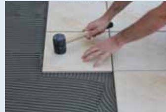
Çekiçle vurulup seviyelendirilmesi
