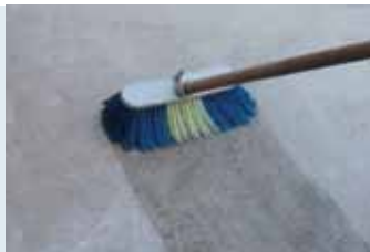
Yüzeyin temizlenip nemlendirilmesi
