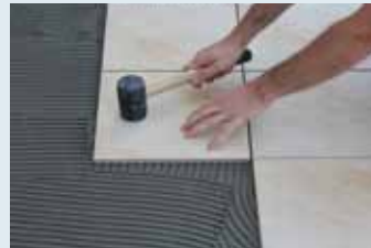
Çekiçle vurulup seviyelendirilmesi
