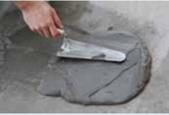
Harçın mala yardımı ile yüzeye aktarılması
