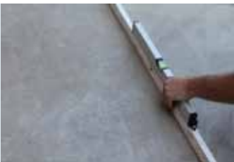
Yüzeyin düzgünlüğünün kontrol edilmesi
