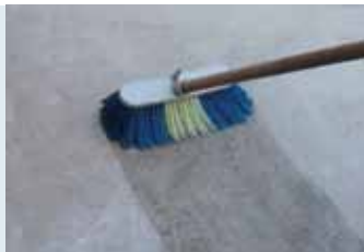
Yüzeyin temizlenip nemlendirilmesi
