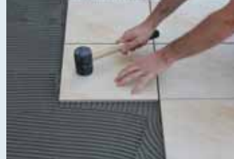
Çekiçle vurulup seviyelendirilmesi
