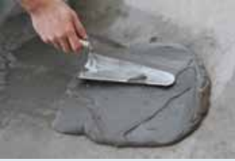
Harçın mala yardımı ile yüzeye aktarılması
