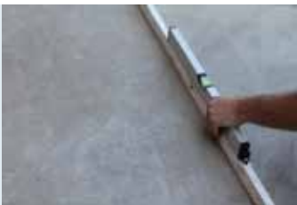
Yüzeyin düzgünlüğünün kontrol edilmesi
