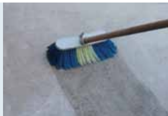
Yüzeyin temizlenip nemlendirilmesi
