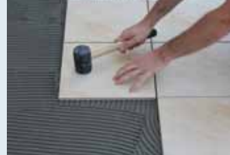
Çekiçle vurulup seviyelendirilmesi
