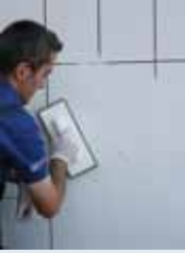
Dolgu malzemesinin duvara uygulanması
