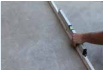
Yüzeyin düzgünlüğünün kontrol edilmesi
