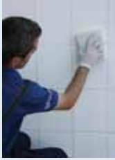
Nemli sünger ile derz yüzeyinin düzeltilmesi
