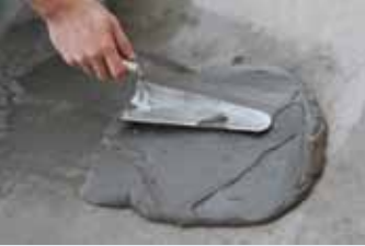
Harçın mala yardımı ile yüzeye aktarılması
