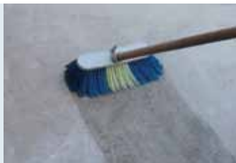
Yüzeyin temizlenip nemlendirilmesi
